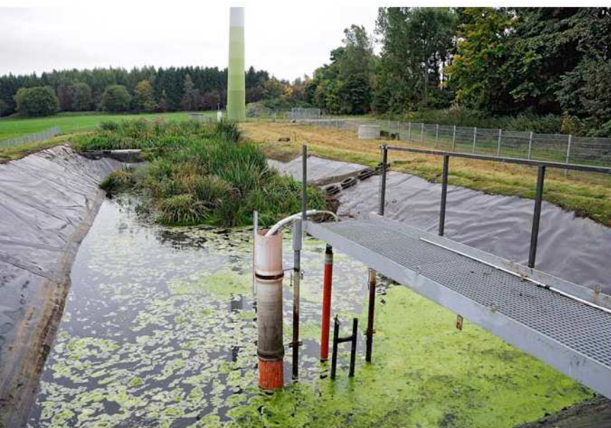
Im Gegensatz zum Absetzteich (Hintergrund) hat das Pufferbecken nach dem Überlauf einen schwankenden Wasserstand.
