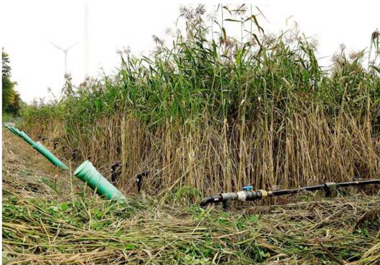
Um einen Druckausgleich zu gewährleisten, wurden die Drainagerohre am Boden des Vertikalfilters beidseitig bis an die Oberfläche verlängert.
