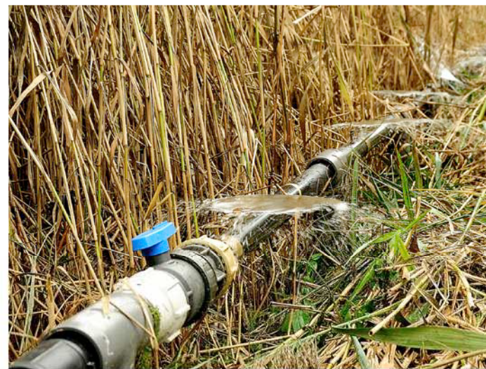
Über Rohrleitungen mit Öffnungen an der Oberseite wird das Abwasser auf der gesamten Fläche des mit Schilf bepflanzen Vertikalbodenfilters verteilt.
