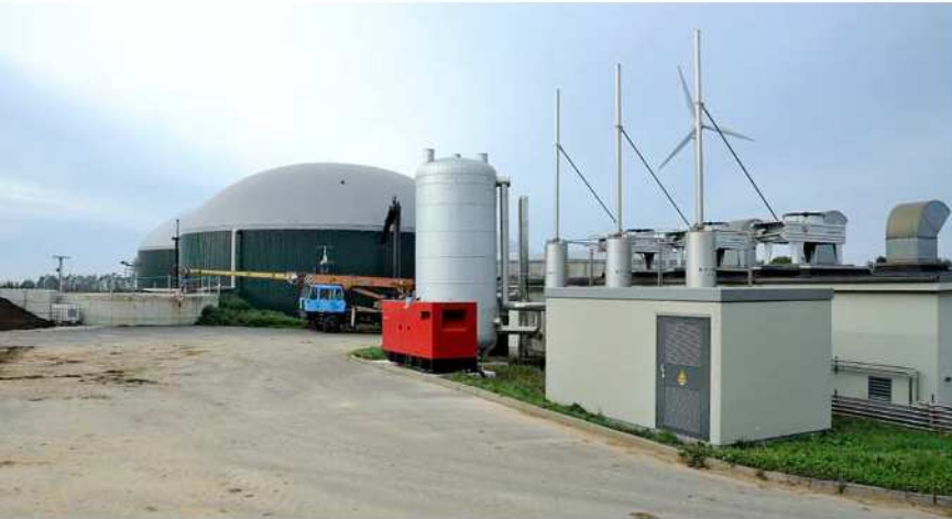
Die güllebasierte Biogasanlage der Sadisdorfer Agrar AG mit einer Leistung von 750 kW wurde im Zuge der Erweiterung der Milchviehanlage errichtet.
