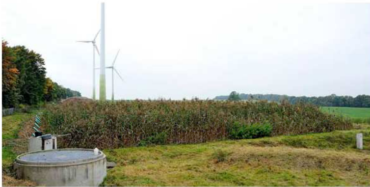
Beschickungsschacht mit dahinter liegendem Vertikalbodenfilter.
