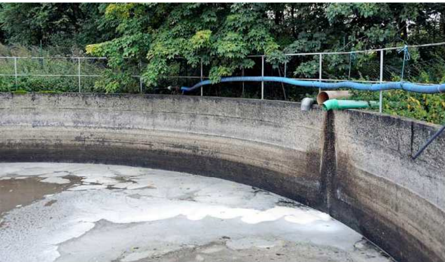
Sammelbehälter für die Sickersäfte und den first flush des Niederschlagswassers aus der Siloanlage.
