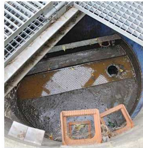
... gelangt das Niederschlagswasser über die Überfallkante in die tiefer liegende Rinne, die zur Pflanzenkläranlage führt.
